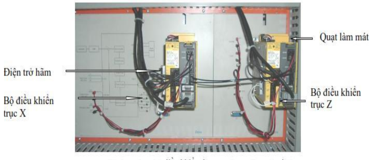
Hình 1: Bộ điều khiển động cơ servo trục X và trục Z
